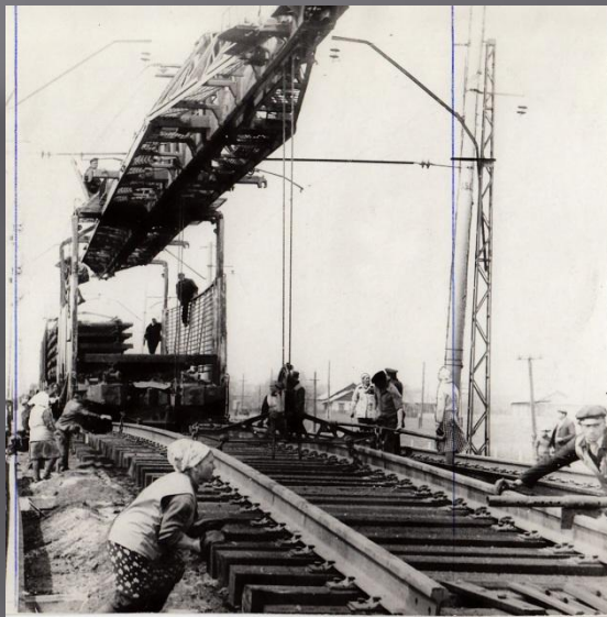
Современная техника на укладке рельсовых звеньев на железной дороге. 1984 г., автор В. Некрасов. Ф.1ф, оп.1ф, д. 125
