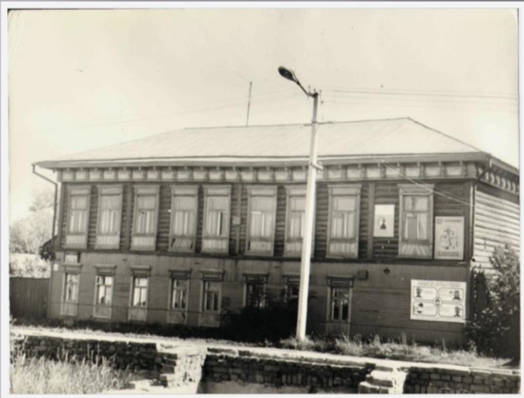
Старое здание медицинского училища по ул. Л.Толстого. 1990 г., автор – не известен. Ф.1ф, оп.1ф, д. 186
